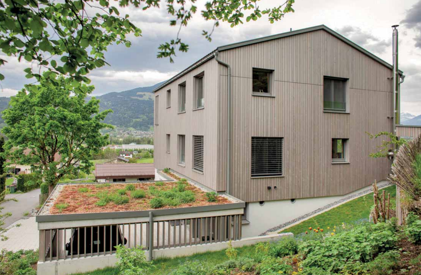
Drei Generationen wohnen unter einem Dach: Die Dachdecker- und Spenglerarbeiten führte die Firma Entner-Dach GmbH & Co. KG aus.
