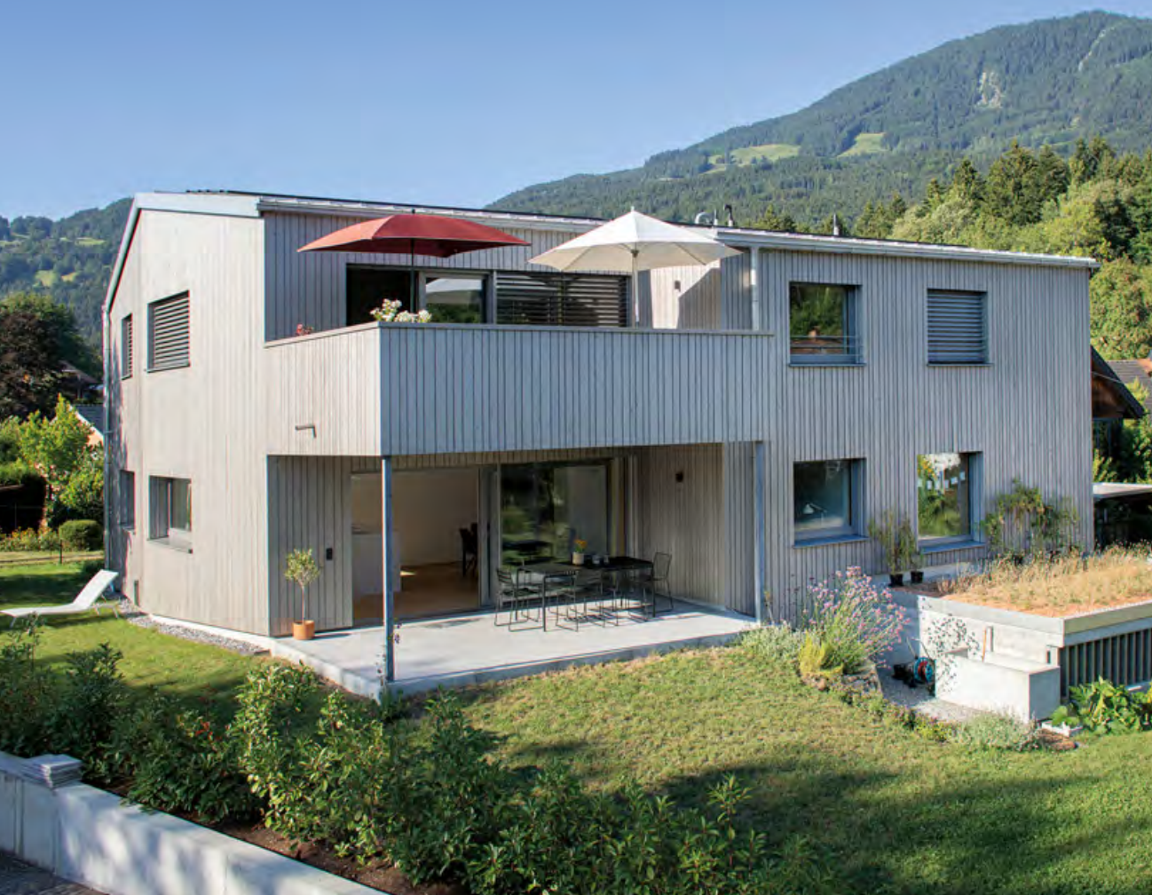
Der vorvergraute Holzschirm der Fassade passt wunderbar zu den hellen Terrassenplatten von der Firma Matt Willi GmbH, die auch die Fliesenarbeiten im Haus ausgeführt hat.
